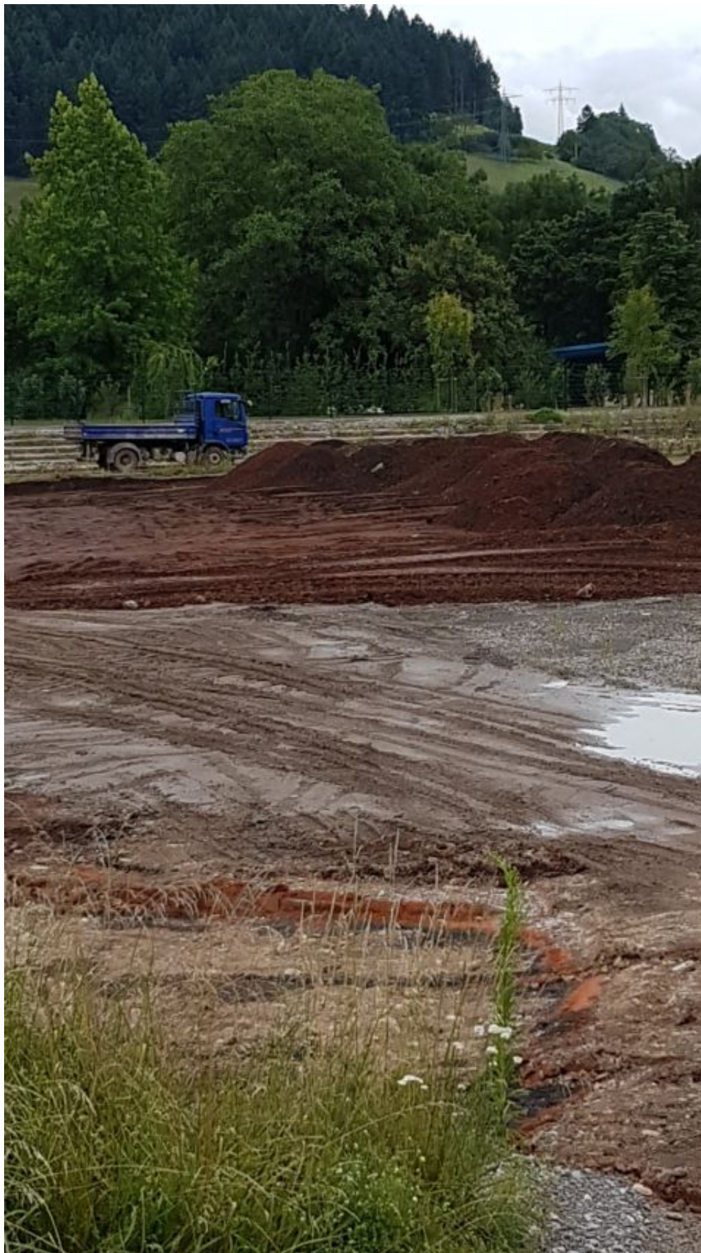
Die rote Asche wird zwischengelagert und später als unterste Schicht wieder eingebaut
